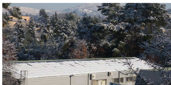
Centrale solaire enneigée du Tiragon, Mouans-Sartoux (06)
