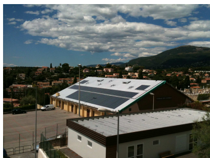
Centrale photovoltaïque Gymnase Dandrés, à Vence (06)
