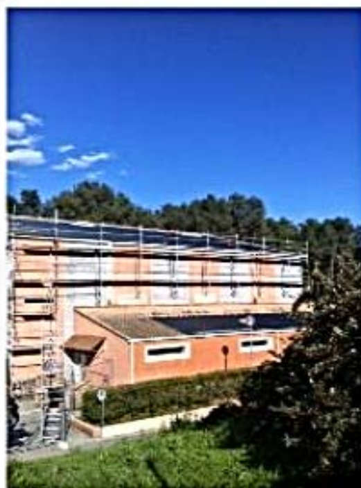
Travaux de toiture en cours à PEYMEINADE
