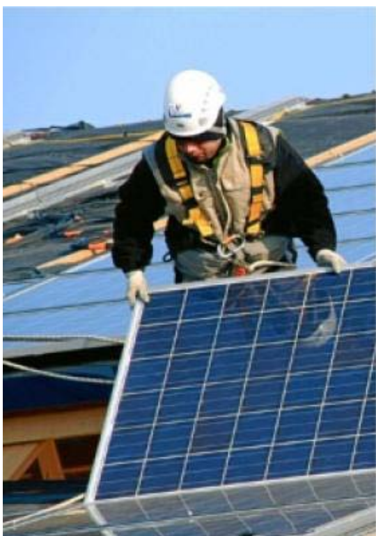
Le nombre d'installations chez les particuliers s'est effondré.
