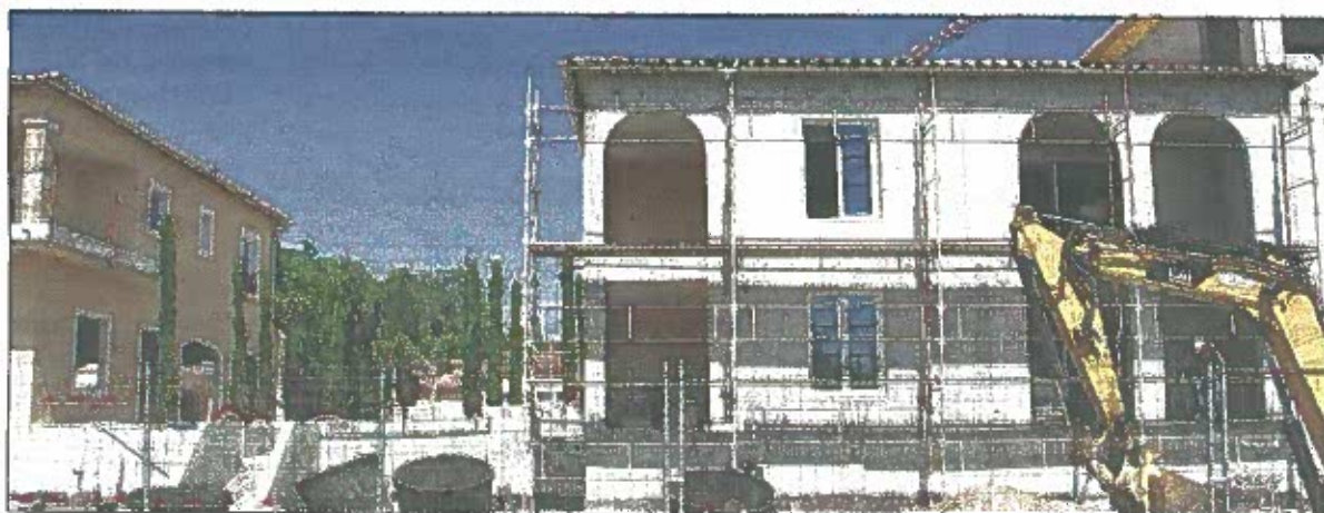
Les travaux avancent très vite, les résidences seront livrées à la fin de l'année. (Photo Fab. B.)
